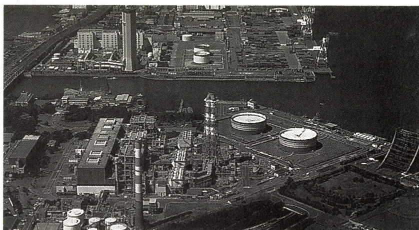
大井ガスタービン (東京電力株式会社提供)
