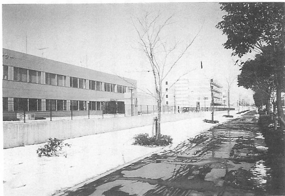
基地跡地に建設中の防災センター
