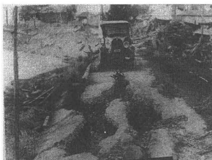
相模川土手の大亀裂
