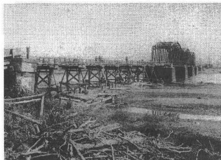
被災した相模橋
