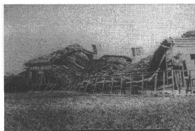
屋根の崩落した厚木蚕業取締所
