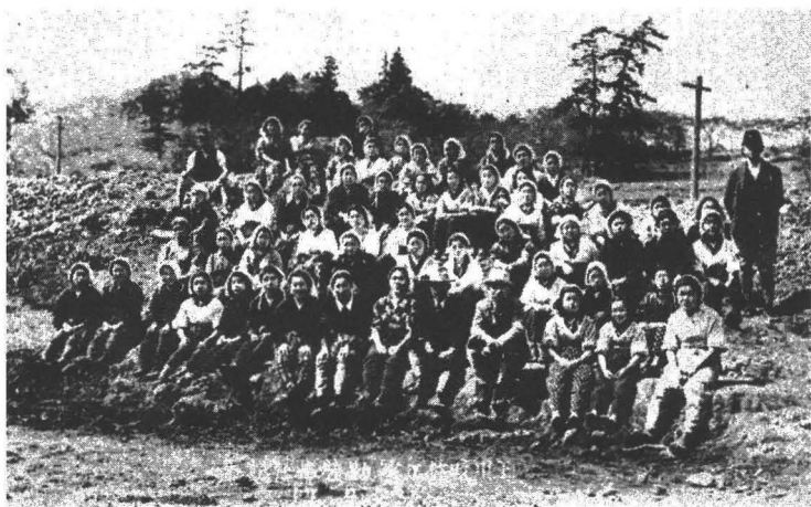
玉川改修工事勤労奉仕
