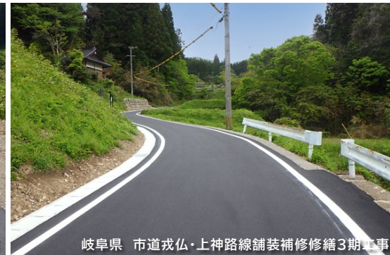
岐阜県 市道戎仏・上神路線舗装補修修繕3期工事
