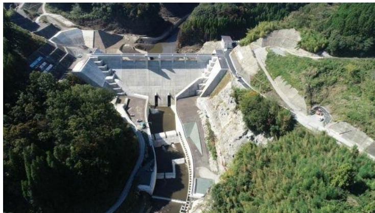
大分県初の流水型重力式コンクリートダムとして完成した「玉来ダム」
