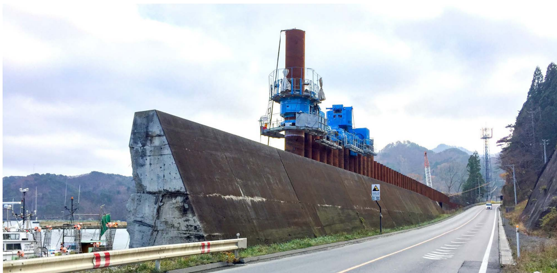
岩手県釜石市の両石漁港海岸復旧における嵩上げ工事
