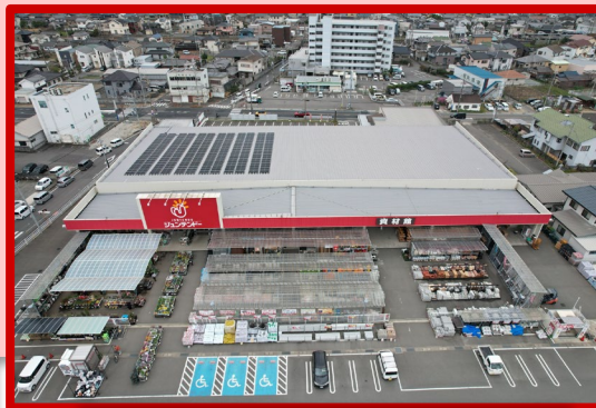
太陽光発電設備設置後の 古屋店(和歌山)の様子
