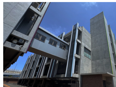
横浜新技術創造館リーディングベンチャープラザ 2 号館
