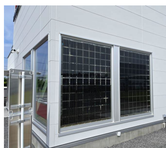
太陽光ガラス設置の様子
