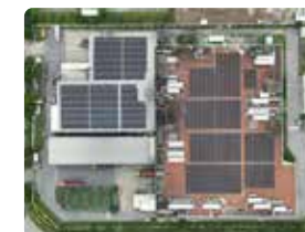
バクニン工場（ベトナム）に設置された太陽光パネル
