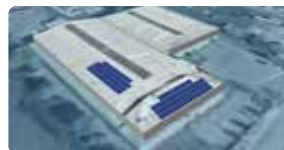
ハンガリー工場の屋根に設置されている太陽光パネル
