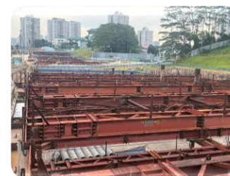
地下鉄（MRT）工事施工風景
