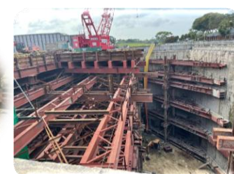
地下鉄（MRT）工事施工風景
