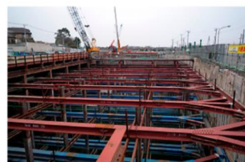
各種仮設解体工事
