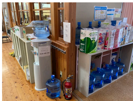
▲能登半島地震時、石川県七尾市の避難所に設置したクリクラ。
