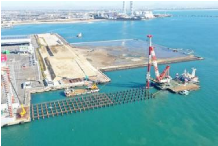
令和5年度 四日市港霞ヶ浦北ふ頭地区岸壁（-14m）本体工事（その2）
