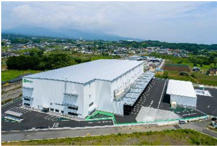
センコー新富士第2 PDセンター新築工事
