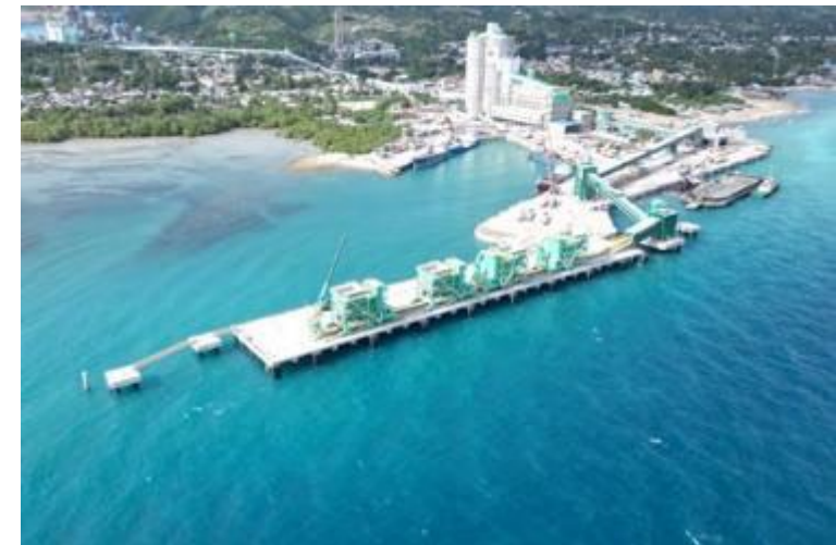
太平洋セメントフィリピンズ新栈橋建設工事
