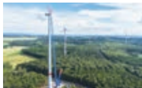
風力発電設備組み立て
