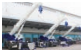
志度工場塗装棟
