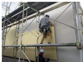
(QDパネル施工風景)
