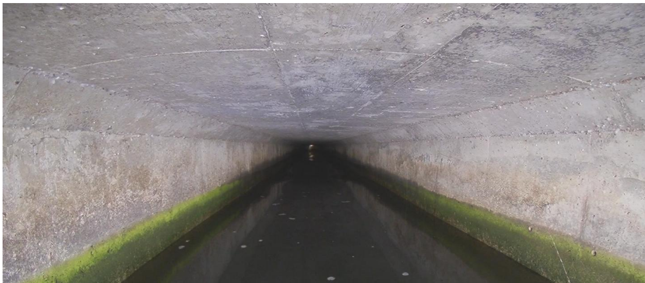
〈IBIS2 で撮影した下水道管内の様子〉
