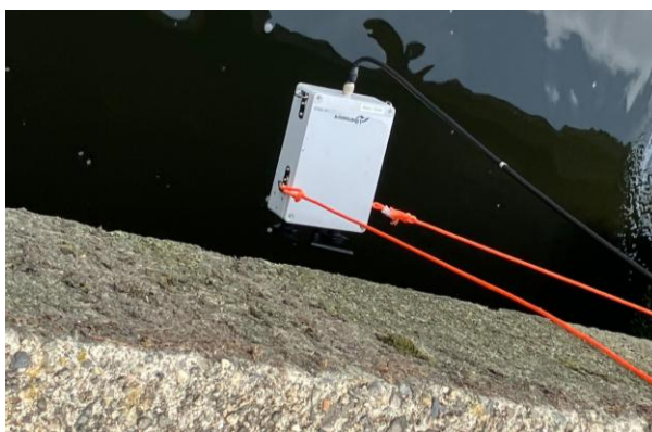
〈ボックスカルバートに電波中継器を接近させている様子〉
