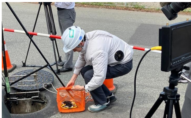
〈下水道管に IBIS2 を進入させる様子〉
