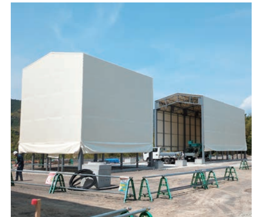
グリーンアローズ中部の静岡新工場建設の様子
