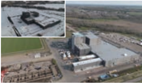
施工状況(2025年5月) (左上)冬季施工状況
