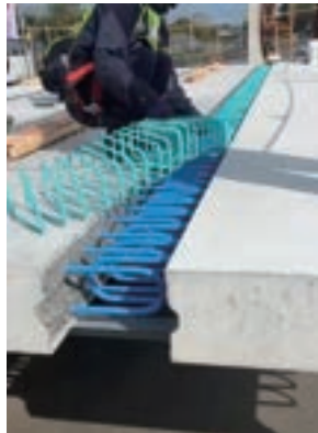
施工性確認試験の実施状況
