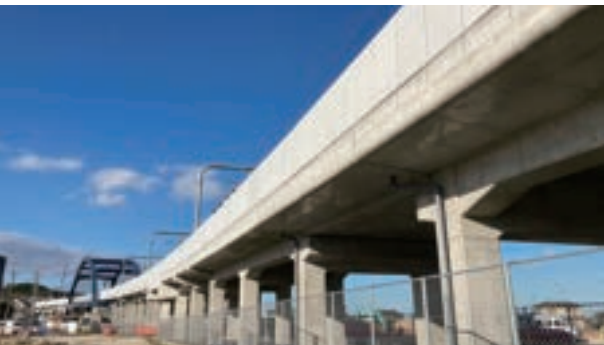
鉄道:河和線 高橋須賀～南加木屋駅間(都)養父森岡線立体交差及び新駅設置事業に伴う本線土木(その4)工事(愛知県東海市)
