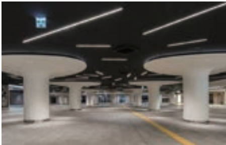
新築された東広場躯体
