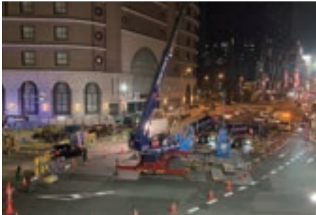
夜間道路規制のなかでの施工状況
