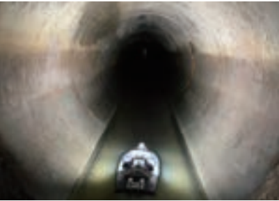
下水道管路内の調査作業
