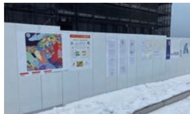
庁舎建設現場(青森県)
