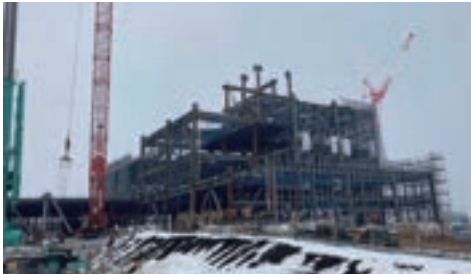
鉄骨建て方状況
