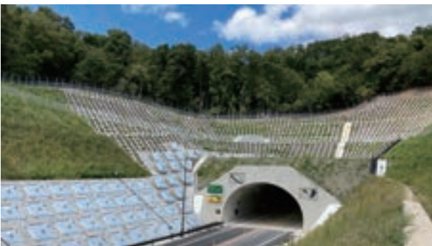
道路:豊岡道路 佐野トンネル工事(兵庫県豊岡市)
