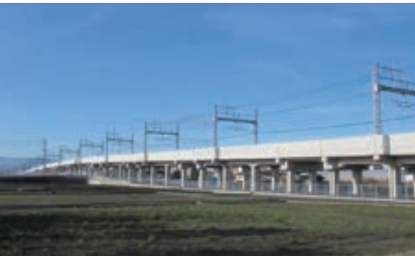
鉄道:長野線喜志・富田林間立体交差化工事(大阪府富田林市)
