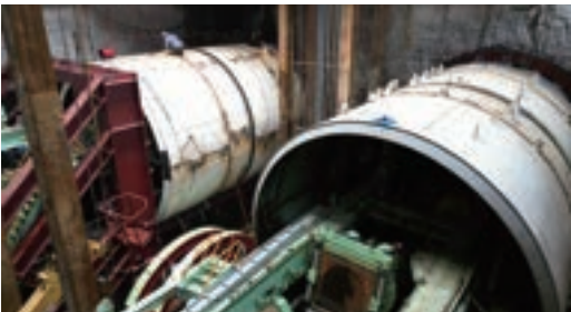
シールドマシン組立の様子
