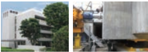
技術研究所管理棟
