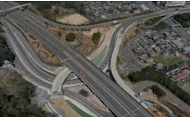
道路:坂出北インターチェンジ改築工事(香川県坂出市)
