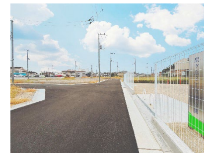
エスリードハウス枚方市星丘 (仮称) 造成完了
