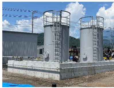
△バイオ燃料 プラント
