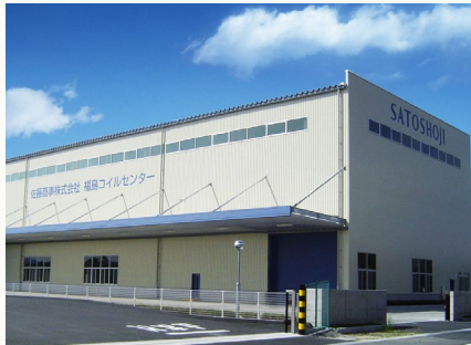
郡山コイルセンター 福島県田村市
