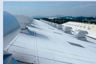
建屋・屋根改修
