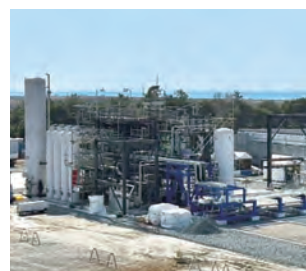
▲建設中の水素製造設備
