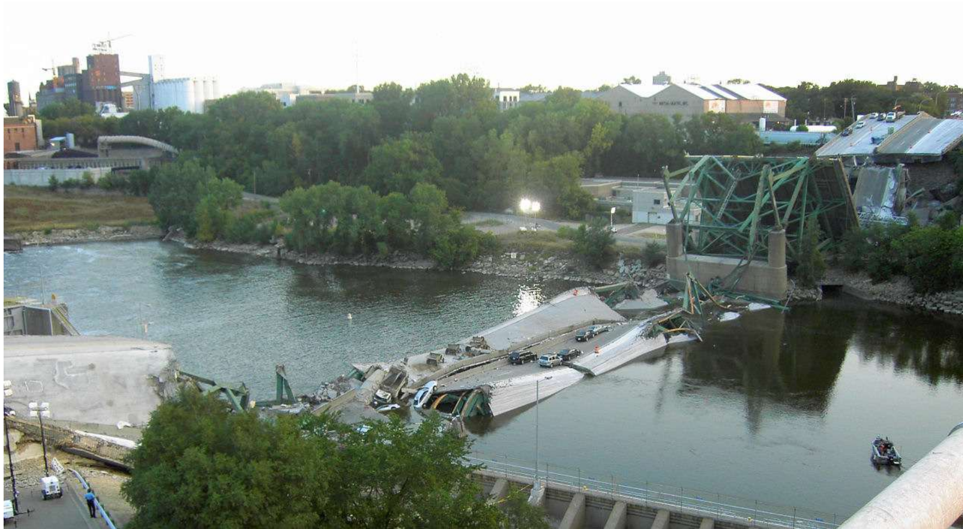
出所：2007年8月1日ミネソタ州で発生したミネアポリス高速道路崩落事故の様子（2007年8月2日 Mike Wills 撮影）
