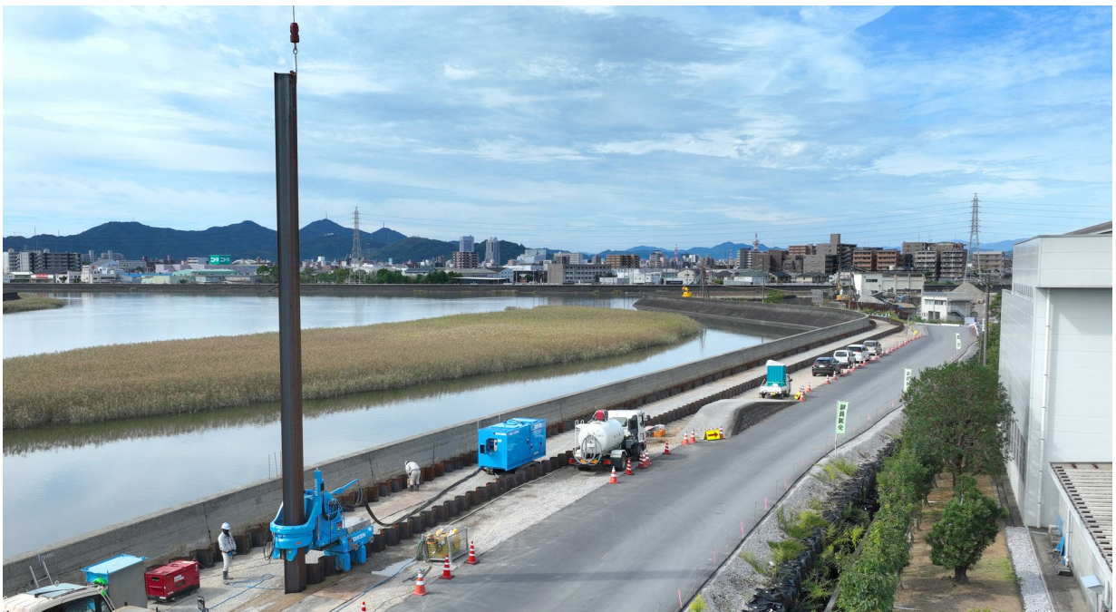
ハット形鋼矢板を用いた堤防補強工事の様子
