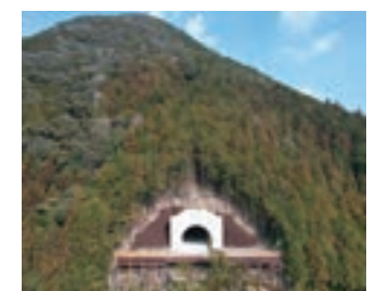
奥瀬道路(3期)2号トンネル他工事 発注者: 国土交通省近畿地方整備局
