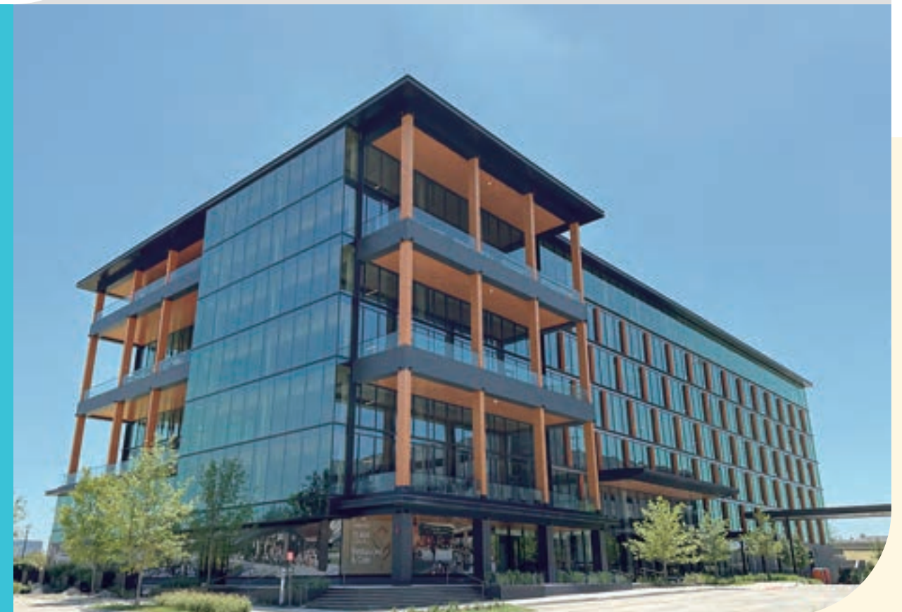
熊谷組が開発に参画した米ダラス近郊で最大規模の木造7階建てESG配慮型オフィス
