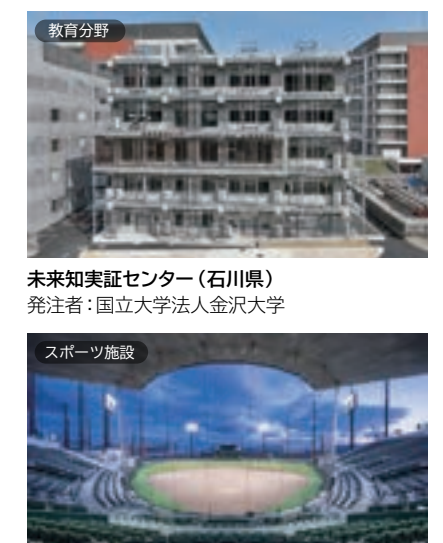
未来知実証センター (石川県) 発注者：国立大学法人金沢大学
