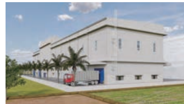
施工中の日系企業の工場
