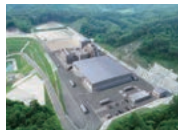
飯館みらい発電所
