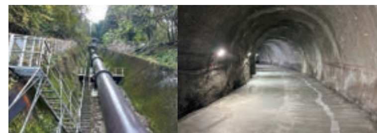
左) 栃本発電所土木建築工事並びに関連除却工事 右) 栃本発電所導水路新設工事・栃本発電所導水路新設関連除去工事 発注者: 東京発電株式会社
