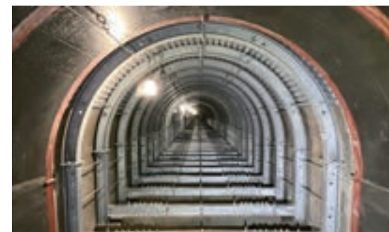
安房峠道路安房トンネル補修工事(2022年度) 発注者: 中日本高速道路株式会社 八王子支社
