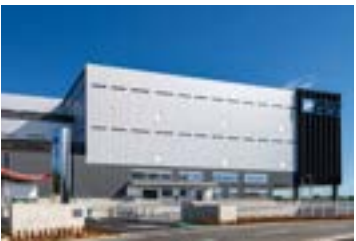
関西工場・関西ハブセンター
