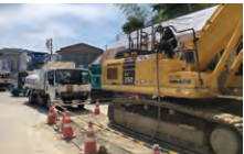
GTLの建設機械への使用 (関東土木支社柿生出張所)
