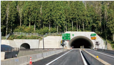
大野油坂道路荒島第2トンネル下山地区工事
