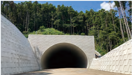
長崎497号松浦1号トンネル新設工事
