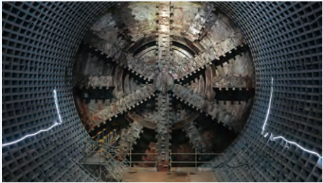
横浜湘南道路トンネルその3工事
