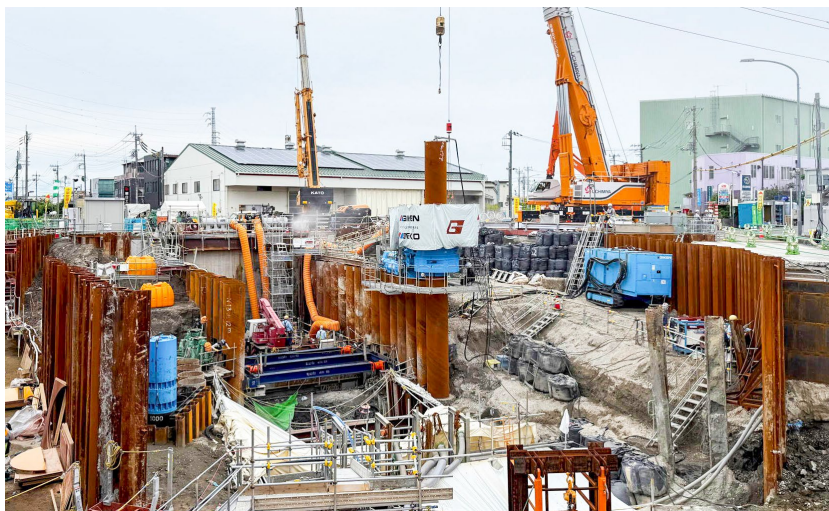
5 月から進められている下水道管復旧作業の様子
