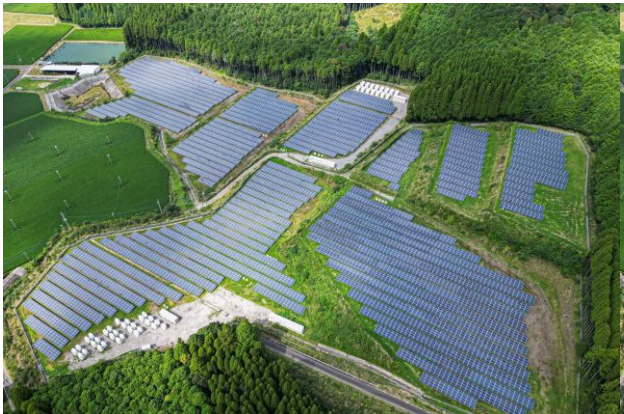
蓄電池設置後の発電所全景
