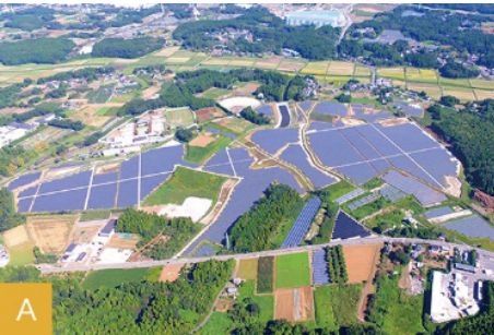
A 茨城牛久メガソーラー発電所 (発電容量29.4MW)
