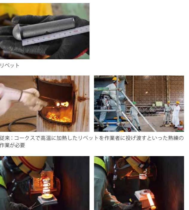
従来: コークスで高温に加熱したリベットを作業者に投げ渡すといった熟練の作業が必要
