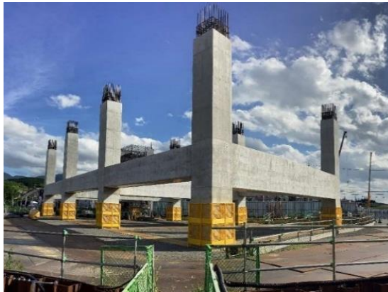
岐阜県駅（仮称） 高架橋工
