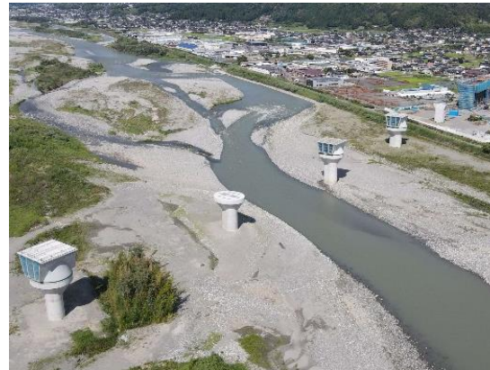
天竜川橋りょう 橋脚工
