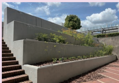
壁面緑化改修
