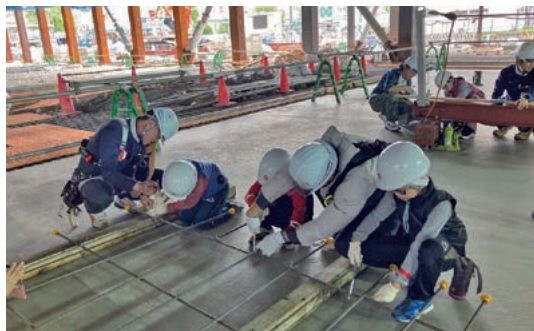
お仕事体験 鉄筋を結束している様子
