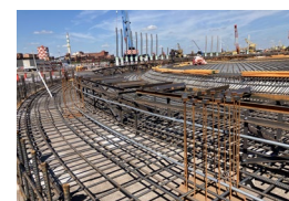
貯蔵タンク 組立予定地(扇島)の現状
