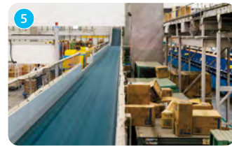
開封され、空になった段ボール回収専用のコンベア
