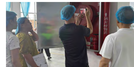
施設や機器類の監査
