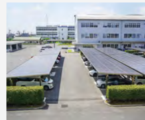
岐阜本社中央駐車場
