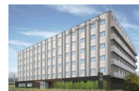
たびのホテル鹿島 2020年4月開業、運営中
