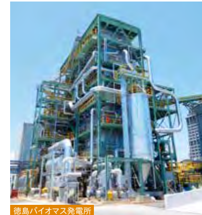
徳島バイオマス発電所
