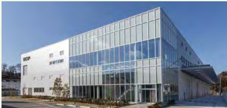
熊本イノベーションセンター新棟
