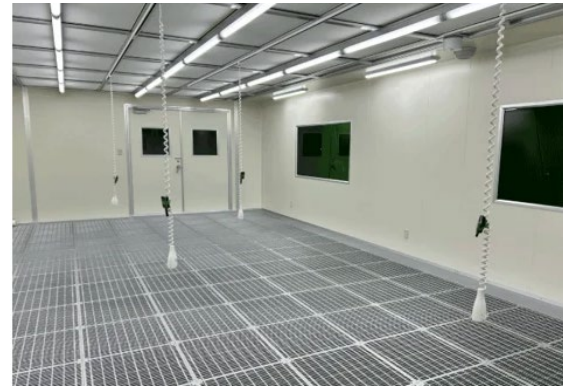
（クリーンルーム内部）
