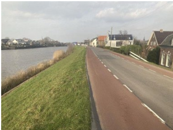
脇に住宅が立ち並ぶ河川堤防
