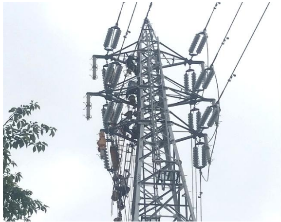
送電線建替え作業の様子
