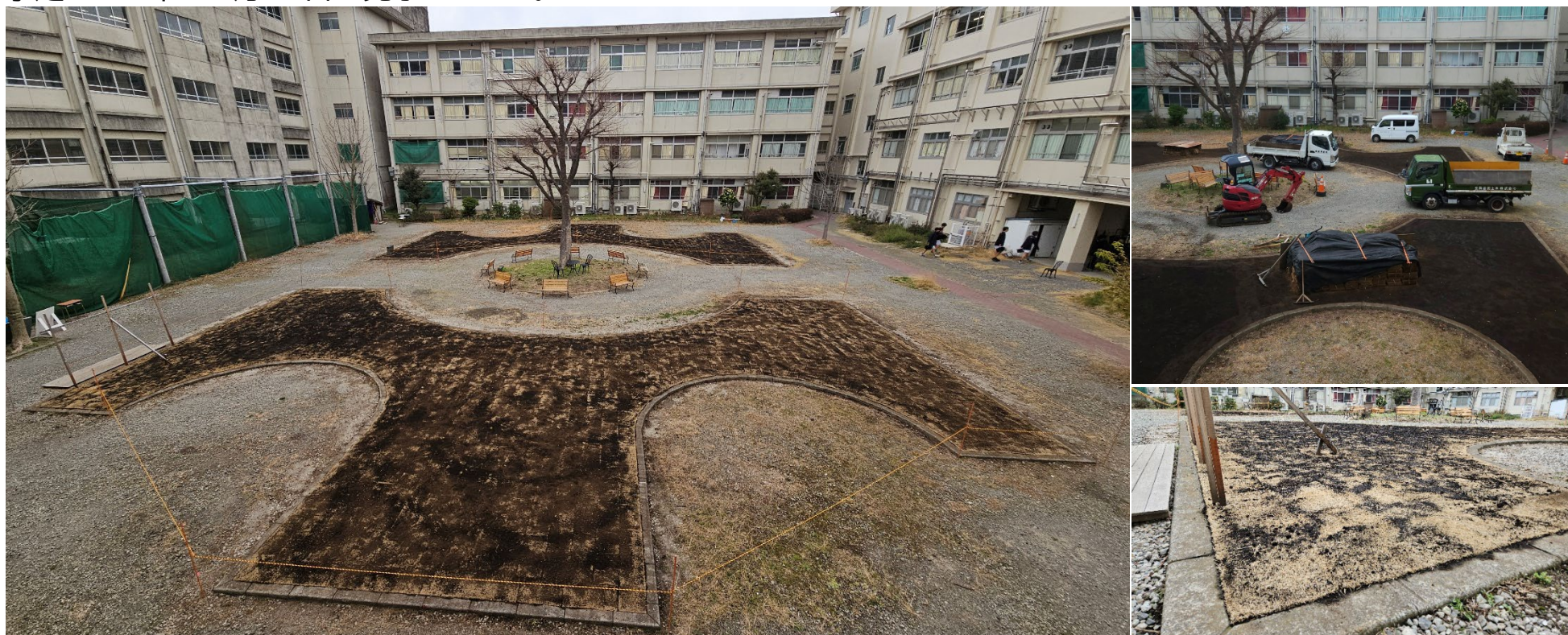
【写真左】全体写真。芝生養生のための囲いがされています。【右上】工事の様子。【右下】芝は隙間なく敷き詰められています。
