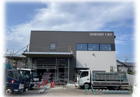
現在建設中の新事務所
