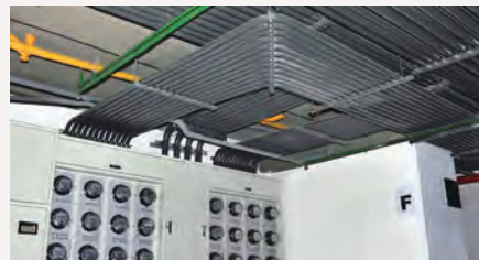
電導管工程 Electrical engineering
