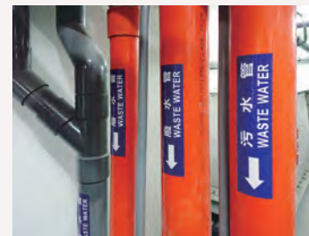
下水道工程 Sewer Engineering
