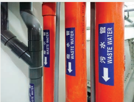
下水道工程 Sewer Engineering
