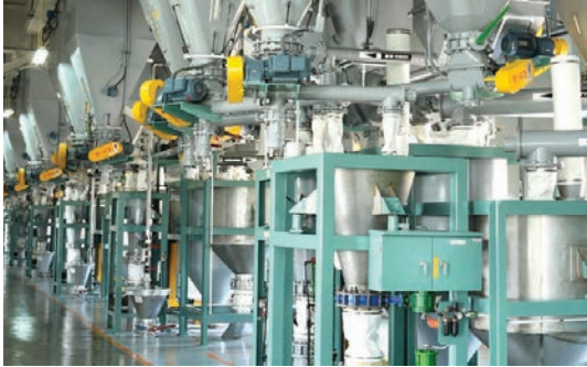
原料計量 Dosing equipment
