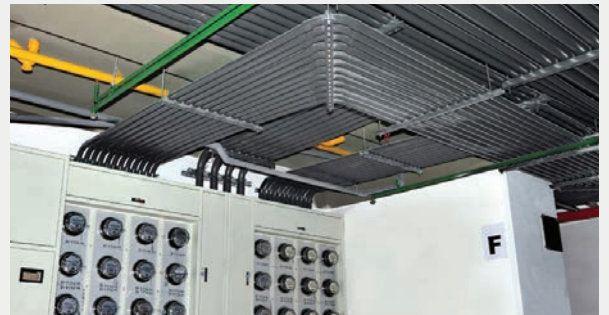
電導管工程 Electrical engineering
