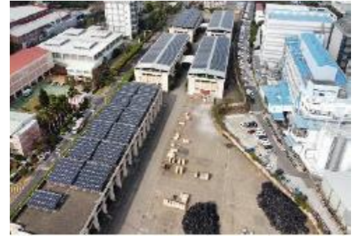
自建中區料庫1.16MWp 太陽能電場 (3.8公頃)
