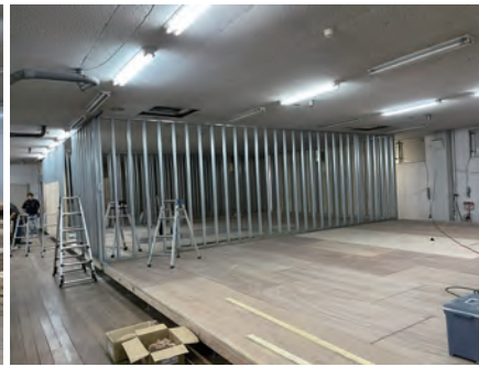
栽培室 4 部屋増設中 (壁)
