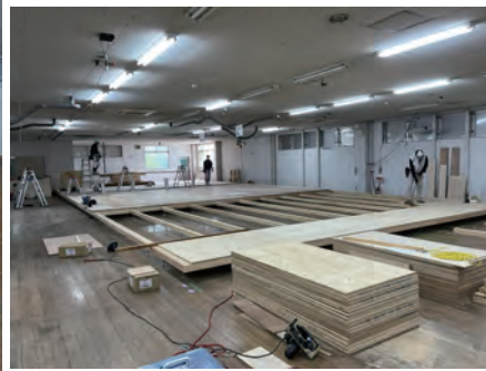
栽培室 4 部屋施工中 (床)
