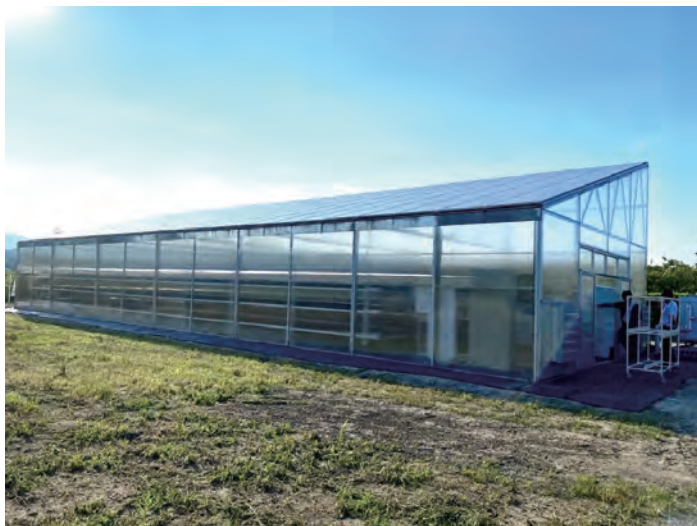
太陽光発電パネル実装ハウス外観
