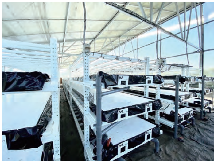
建設中ハウス内部
